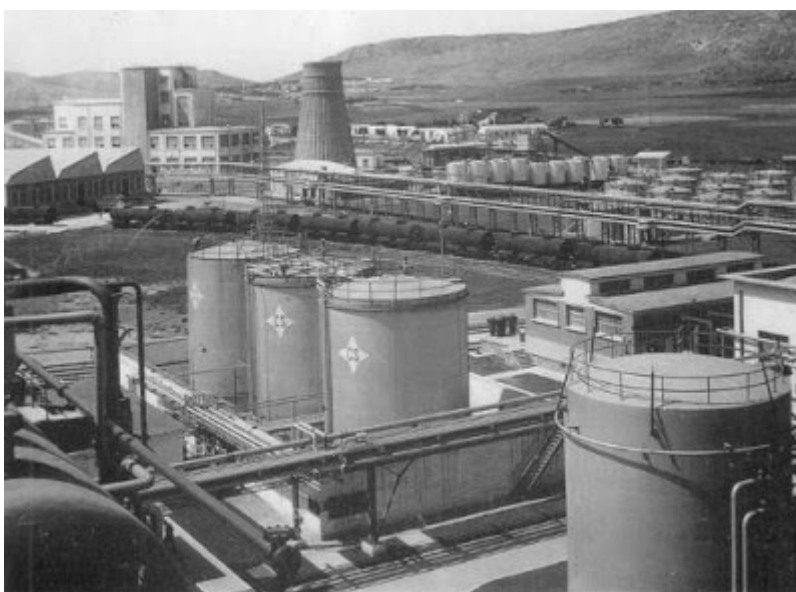
Figura 7: Primeras instalaciones del Complejo industrial de Puertollano
